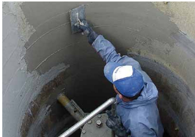
Schnelles Abdichten eines Abwasserschachts mit Vandex-Rapid-Produkten.
