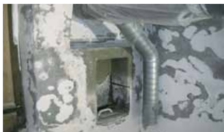
1 Zustand vor Sanierung
