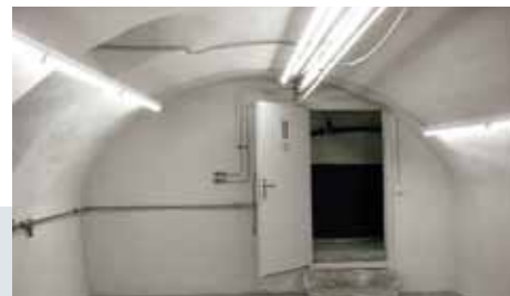
6 Nach Abschluss der Sanierung
