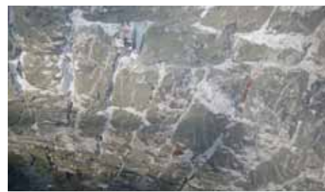
3 Schadhafte Putz ist entfernt
