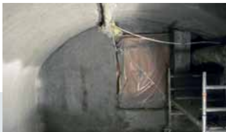
5 Zweite Schicht; VANDEX SANIERPUTZ WTA weiss
