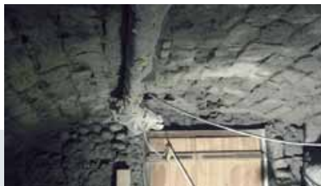
4 Erste Schicht; VANDEX UNIMÖRTEL
